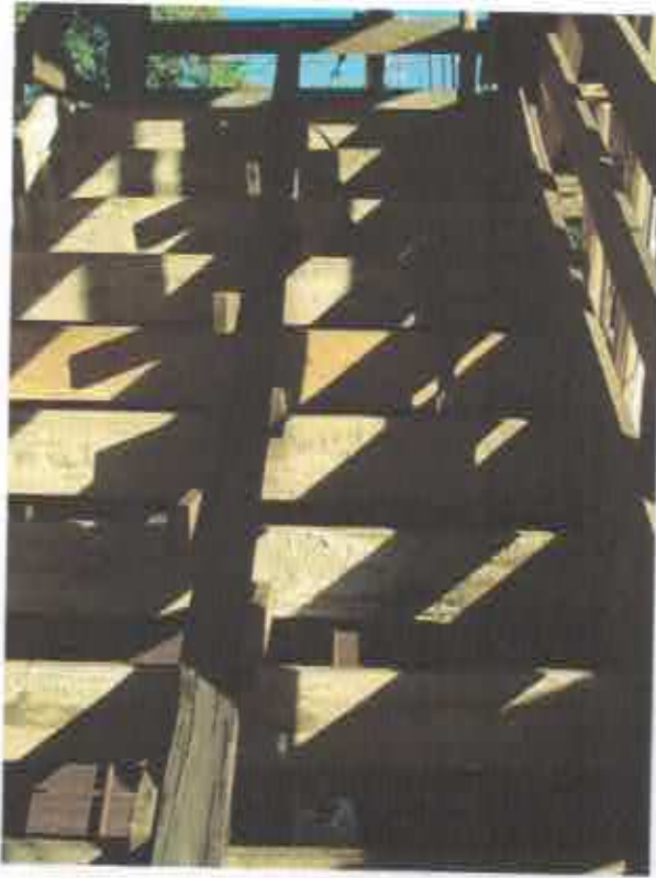
ESCADA DO MEZANINO AO TIPO 1 NÃO CONCRETADA, SÓ COM ARMADURAS E FORMAS.
