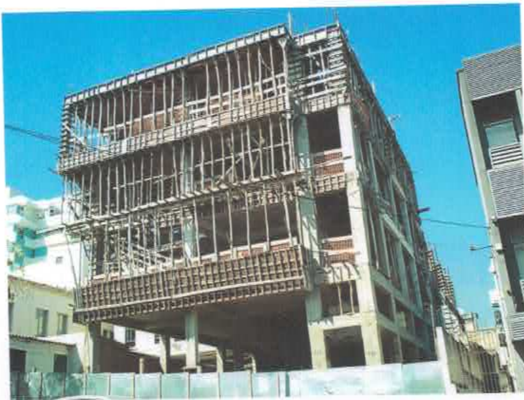
Figura 03 – Foto da Situação Atual da Obra (mar.2015)
