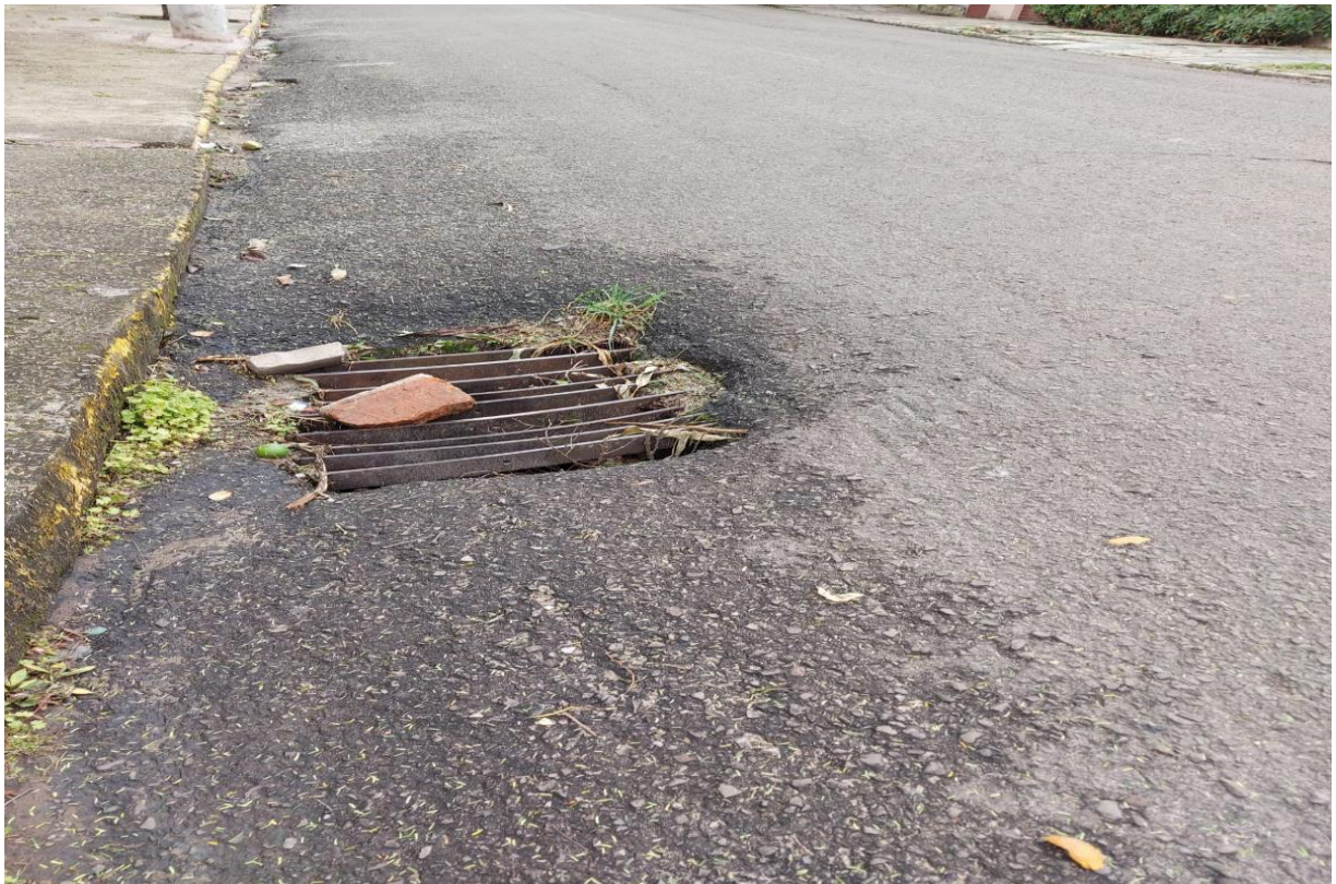
FOTO Nº 04 – BURACO NA REDE DE ESGOTO
