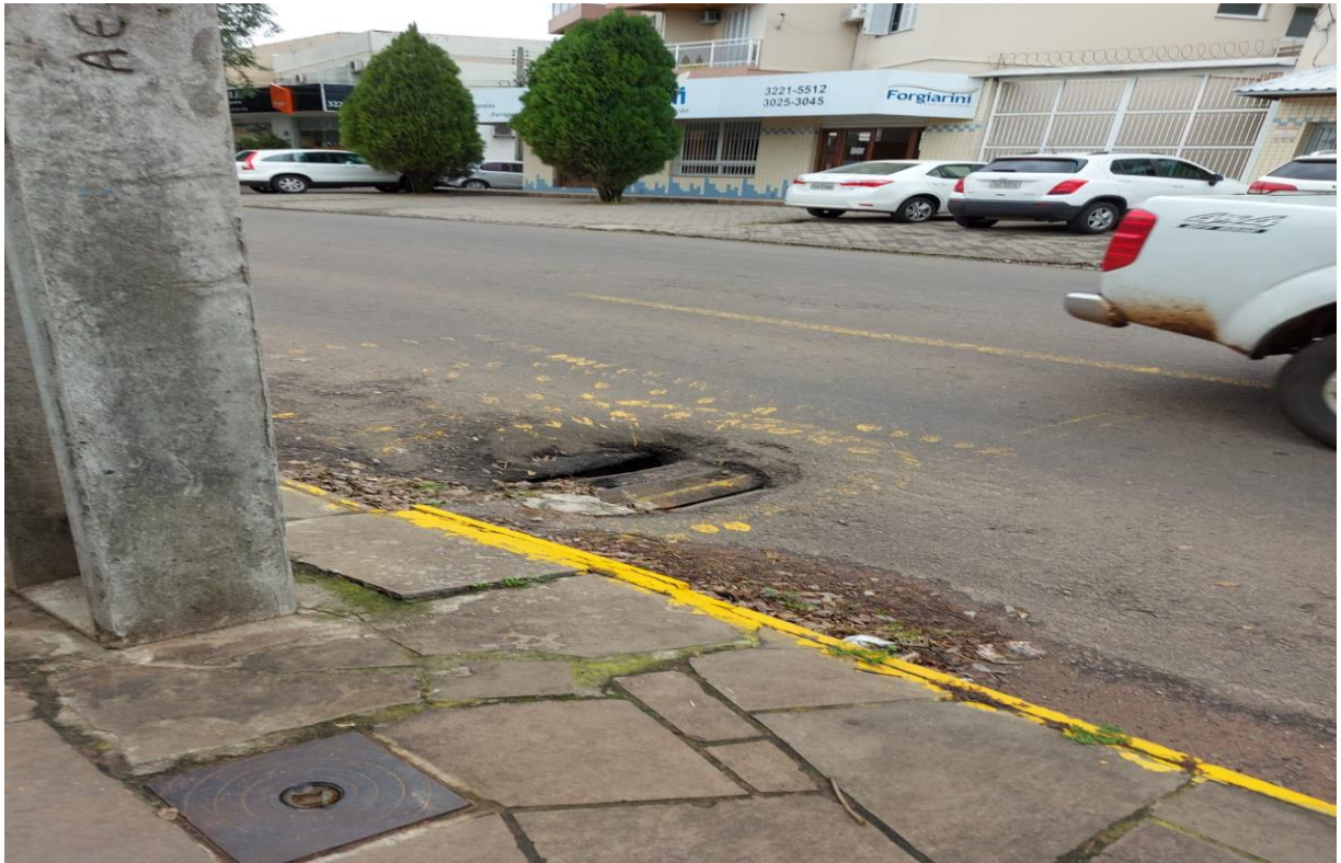
FOTO Nº 04 – BURACO NA REDE DE ESGOTO
