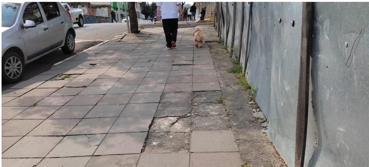
Figura 2-Calçada existente no local
