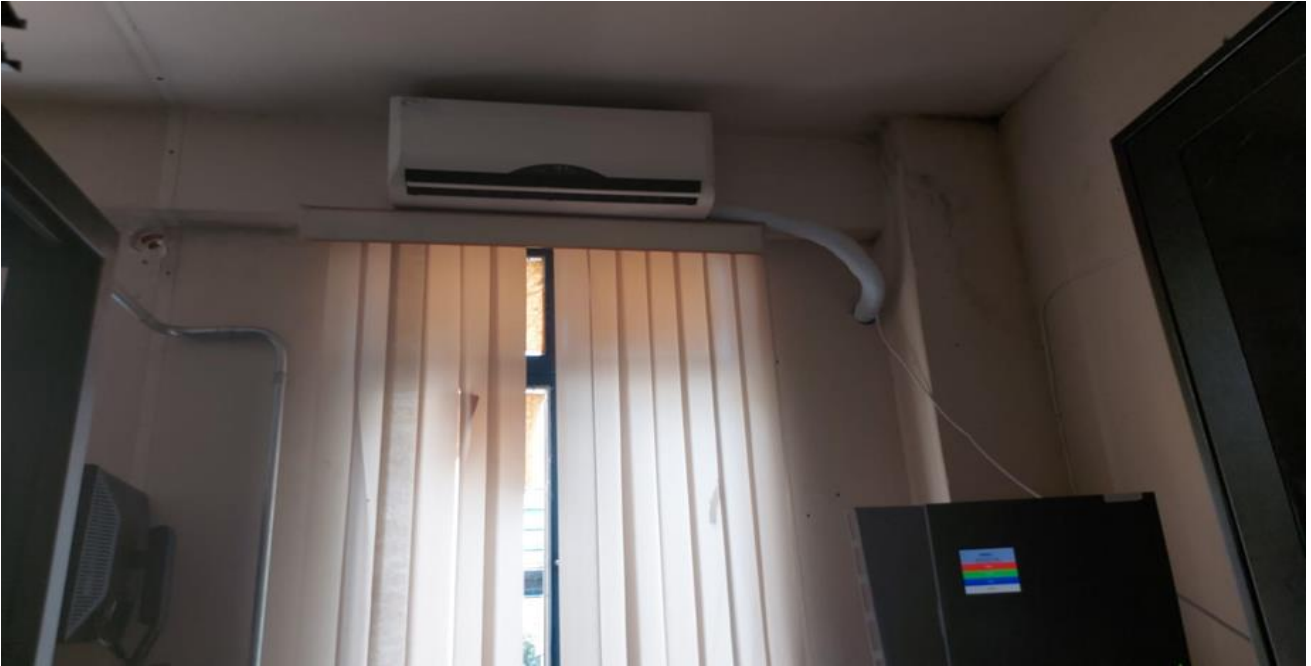
Lote 2 – Unidade interna Divisão de Informática.
